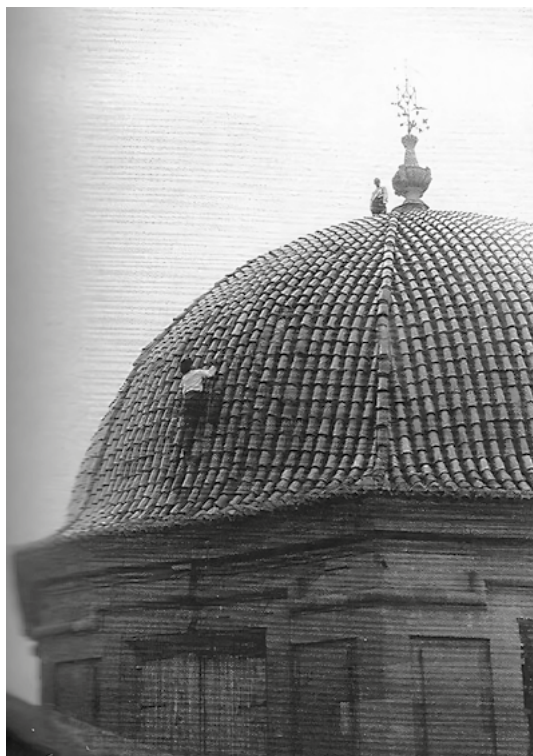
Inicio de las obras de cambio de teja curva a teja plana de la cúpula de Santa María de Elche. 1904. Fuente: García Navarro, J.J.; Navarro Mallebrera, R.; Serrano Bru, A. (2011), "Las huellas del tiempo. Construcción y restauración de la Basílica de Santa María", Ajuntament d'Elx, Elx, p.89.
